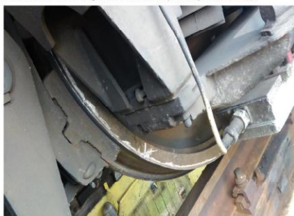
Foto nr.7 Osa deraiată - roata 6 dreapta sens mers
